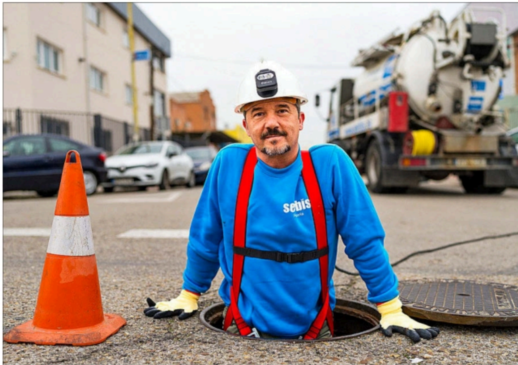
Pedro Gallego, fundador de Serbis Pocería, saliendo de una alcantarilla madrileña. ÁNGEL NAVARRETE
